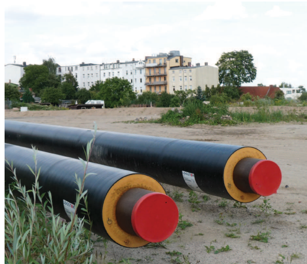
Erweiterung des Fernwärmenetzes in Schwerin-Werdervorstadt
